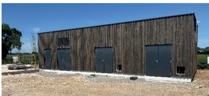
Construction du poste de pompage des eaux usées « Chapitre »
